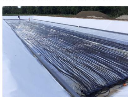
Simandre : dispositif d'aération en cours d'installation dans le bassin (1300 m<sup>2</sup>)
